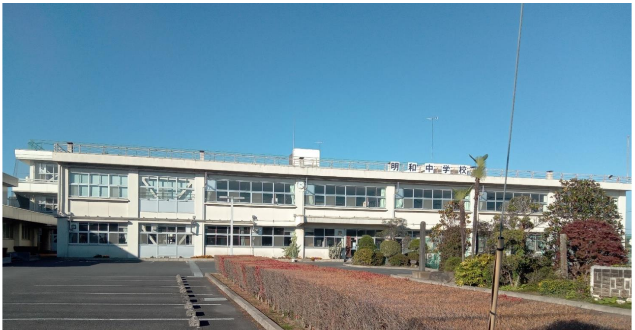
【明和中学校の南校舎（築55年）】
