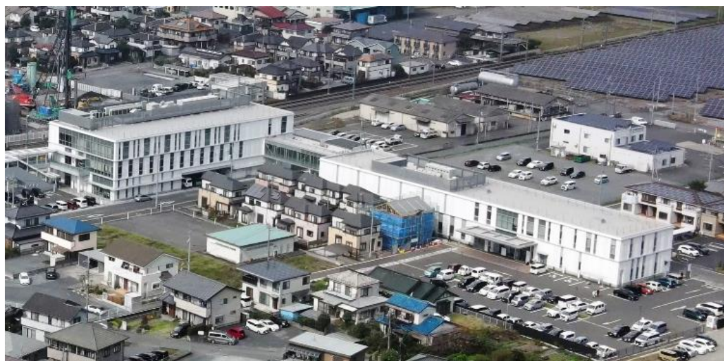
【まちづくり会社が進めてきた医療施設（川俣駅東口）】
